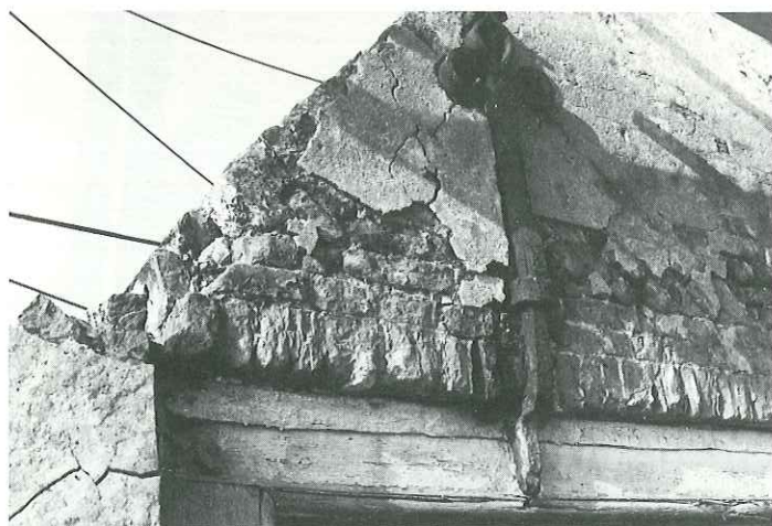
49. Detail, achtergevel, voor restauratie.
