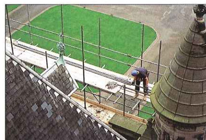
Steigerwerk kapconstructie Foto: Koninklijke Woudenberg Ameide
