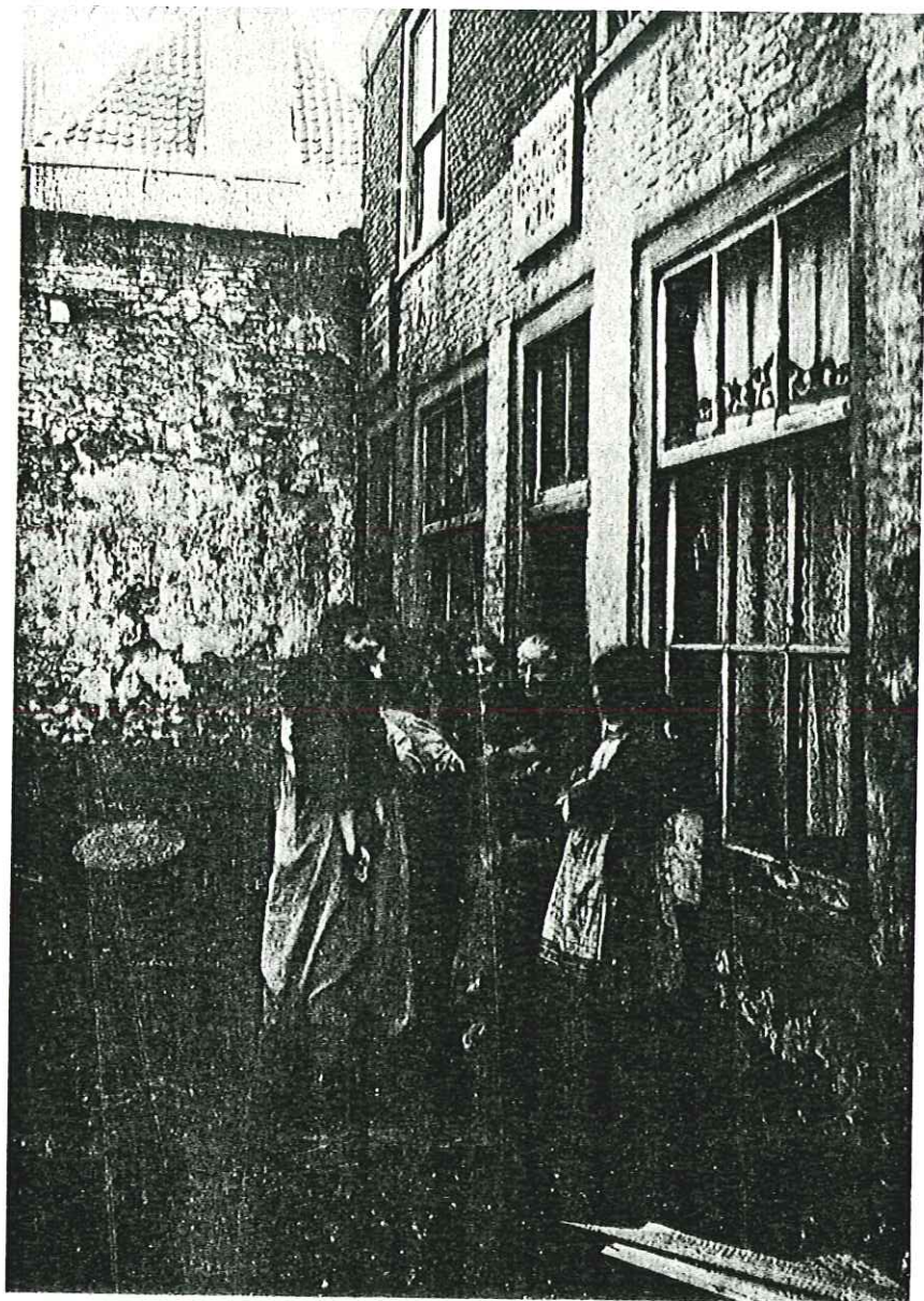
Slop aan de Voldersgracht; boven de deur een bord met 'Onbewoonbaar verklaarde woning', ca. 1910. (Verz. G.A. 's-Gravenhage).
