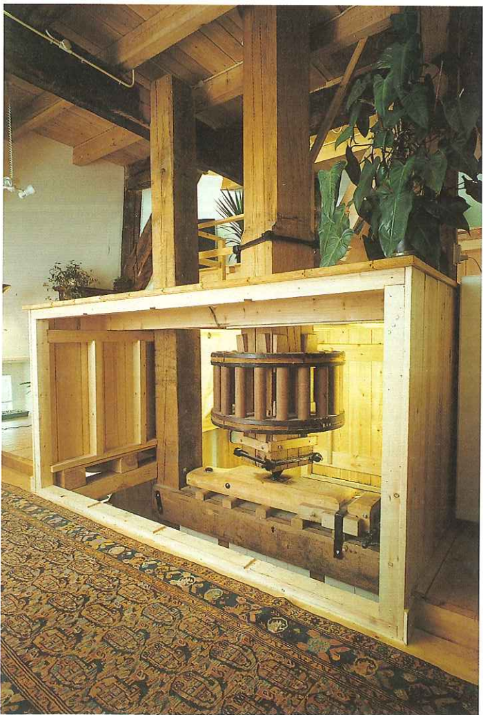
33. Het interieur van de woonkamer op de eerste zolder. De spil en de onderschijf zijn zichtbaar door de transparante omkasting, april 1988.
