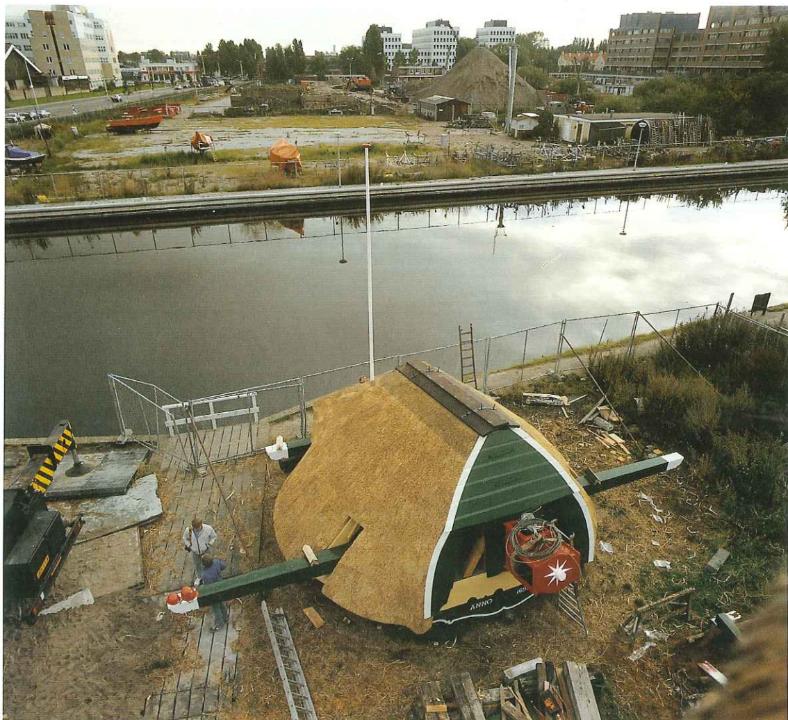
25. De kap gereed voor herplaatsing, 29 september 1987.
