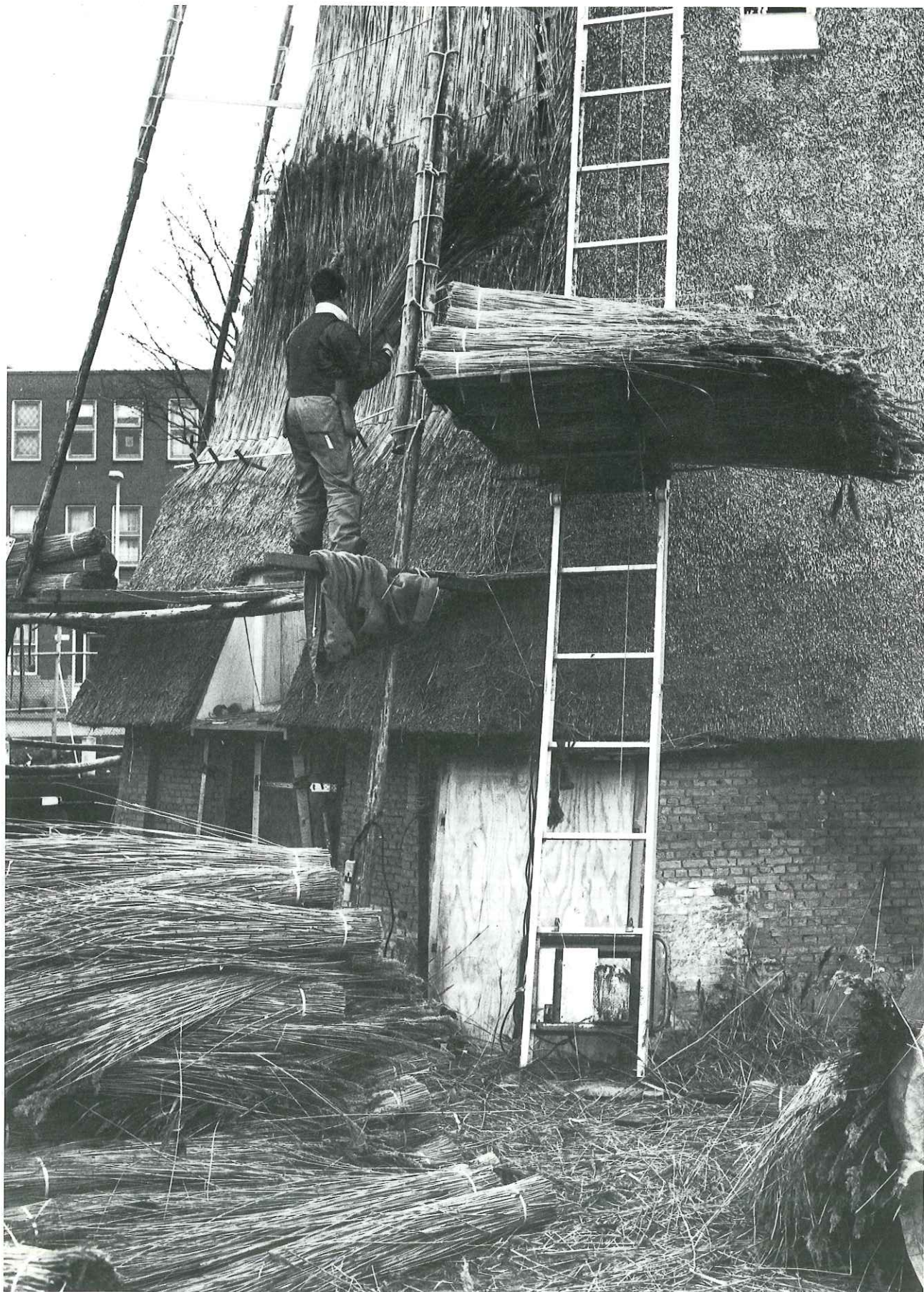
22. De rietdekker aan het werk, 11 februari 1987.
