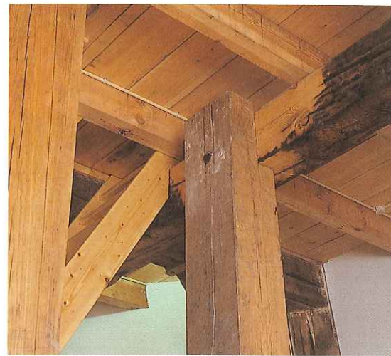
34. Detail constructie op eerste zolder. Zichtbaar is een hergebruikte, door brand zwart geblakerde vloerbalk.
