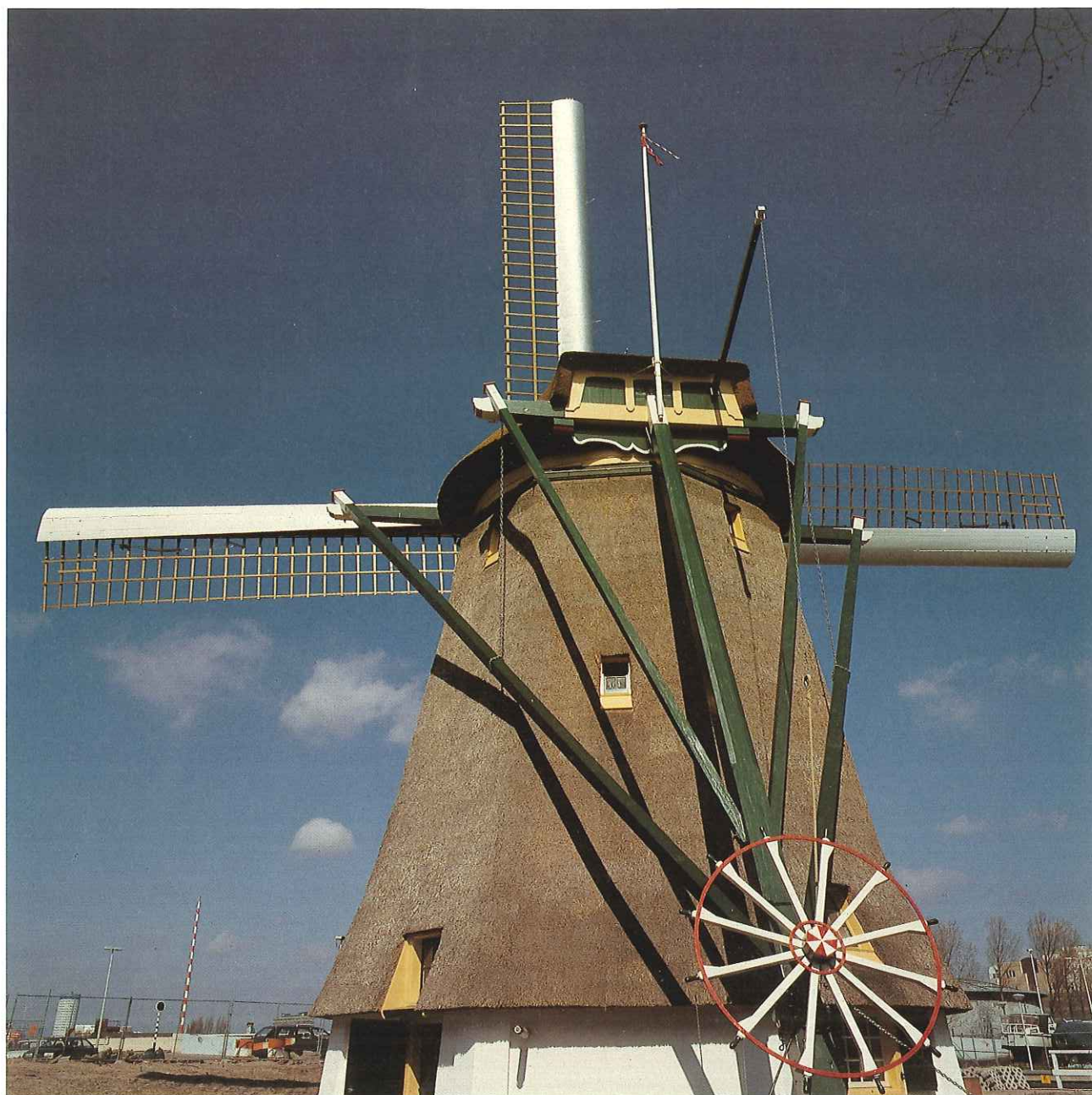
1. De Laakmolen na restauratie, april 1988.
