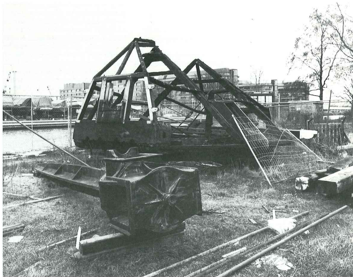
19. De restanten van de kap, met op de voorgrond de afgekeurde gietijzeren as, 18 december 1986.
