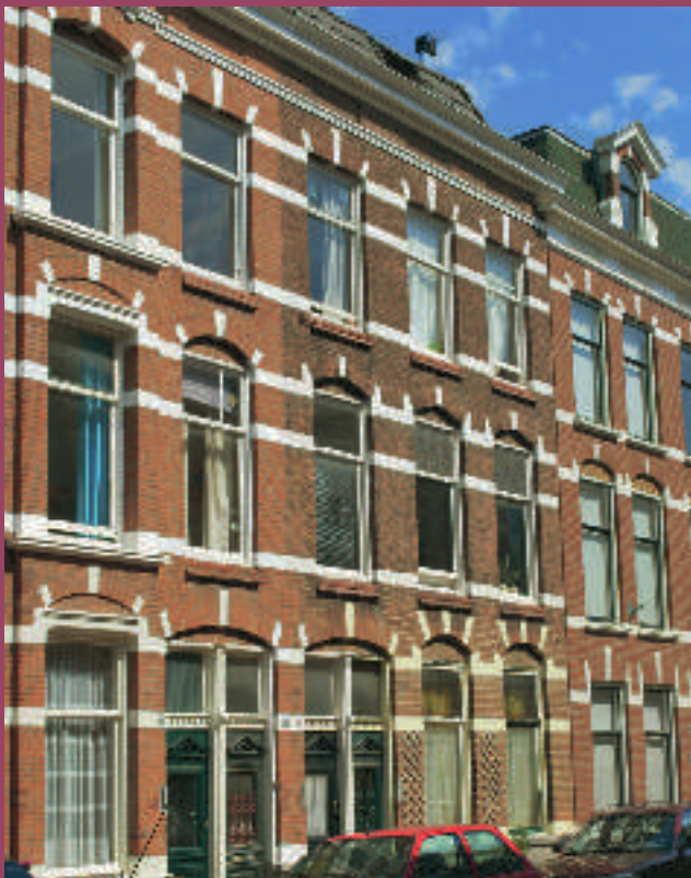
Intensief reinigen van gevels beïnvloedt de eenheid van de straat doordat er kleurverschillen ontstaan tussen identieke gevels
