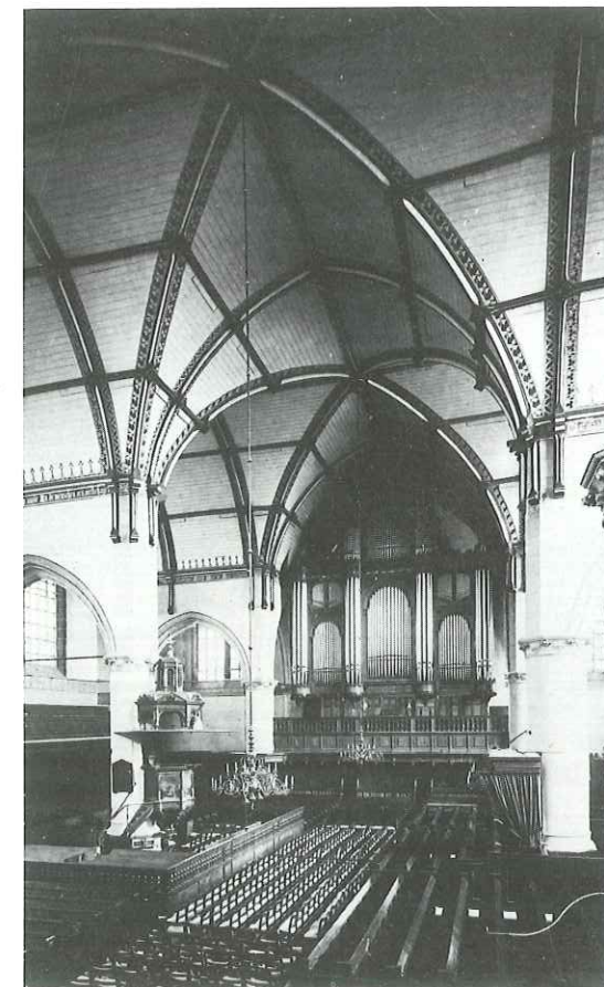
8. De houten gewelfbeschiëting vóór de restauratie 1910-1921.
