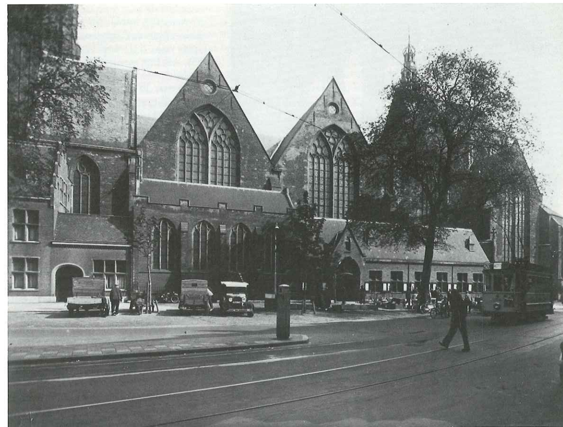
11. Een deel van de kosterwoning en, aan de rechterzijde van de kapel van Assendelft, de nieuwe consistorie.
