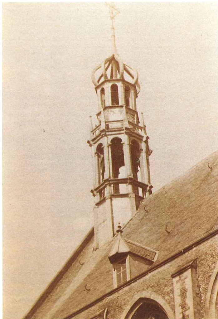
41. Detail van foto uit 1890 waarop goed zichtbaar is dat de beschildering van de toren over de leigedekte vlakken is doorgezet (vgl. afb. 36) en dat zij in twee tinten is uitgevoerd.
