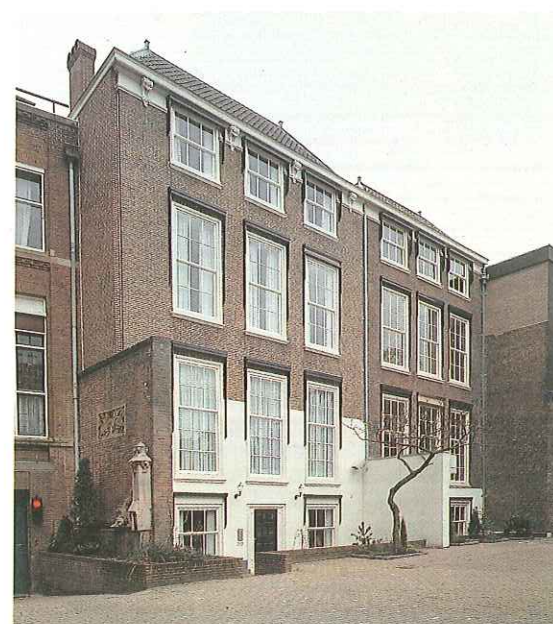
49. De achtergevel in de huidige toestand.
