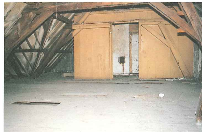
23. Kapsanten van pand Riviervismarkt 3 in de toestand vóór 1986.
