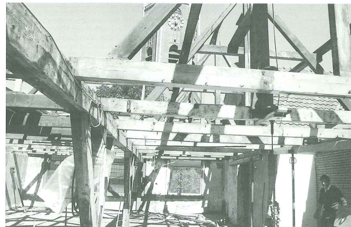
33. De kappanten van het voor- en achterhuis van pand Riviervismarkt 4.
