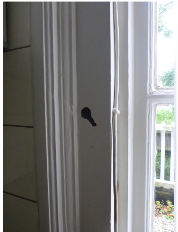
Afb. 20. Detail met een van de scharnieren van de vouwblinden aan de binnenzijde. Rechts daarvan de sluitstang
