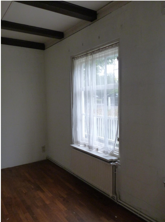
Afb. 19. Een van de vensters in de voorgevel
