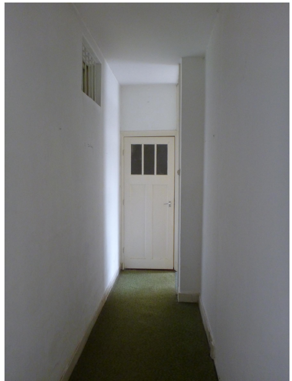
Afb. 18. De gang op de begane grond. Links de achtergevel met een van de hoog geplaatste vensters
