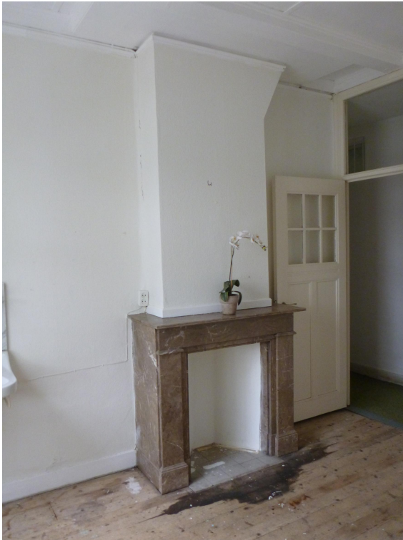
Afb. 22. De schouw tegen de bouwmuur in het rechter vertrek
