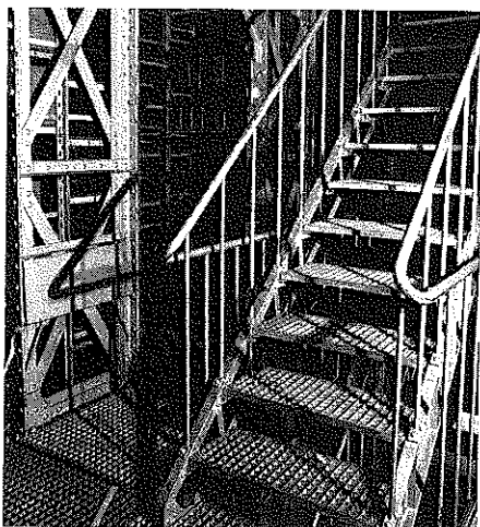
3 ARA-depot; een van de steektrappen (van niveau 3 naar 4); strakke, uiterst functionele vormgeving (vgl. afb. 8).
