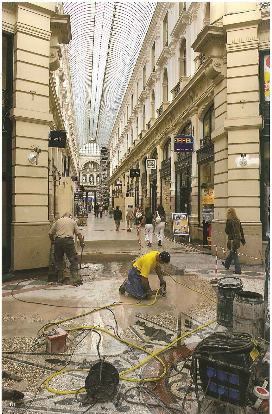
6) Niet overal was de vloer dik genoeg om goed diep te kunnen schuren. Voorzichtig aan, en met de handschuurmachine dus.
