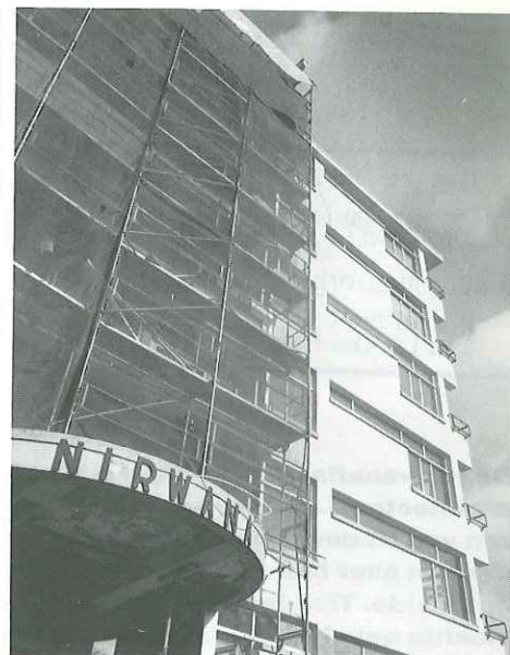
Tijdens de renovatie hebben de bewoners maanden achter steigers en afschermkleden vertoeft.
