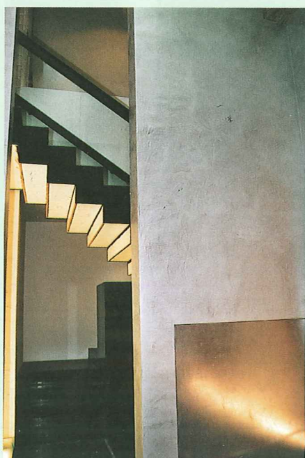
Het trappenhuis vanuit de foyer op de begane grond: een lust voor het oog.
