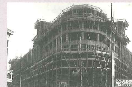
Tijdens de bouw, oktober 1953. (Verzameling Museum voor Communicatie)
