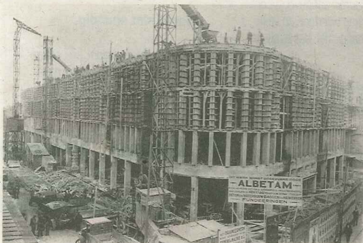
- Hoek van de Grote Marktstraat en de Wagenstraat, de Bijenkorf in aanbouw in 1925. Foto: archief architect Piet Kramer. -
