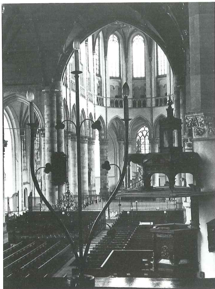
13. Een deel van de banken en het koorhek na de restauratie 1910-1921. Zie ook afb. 8.
