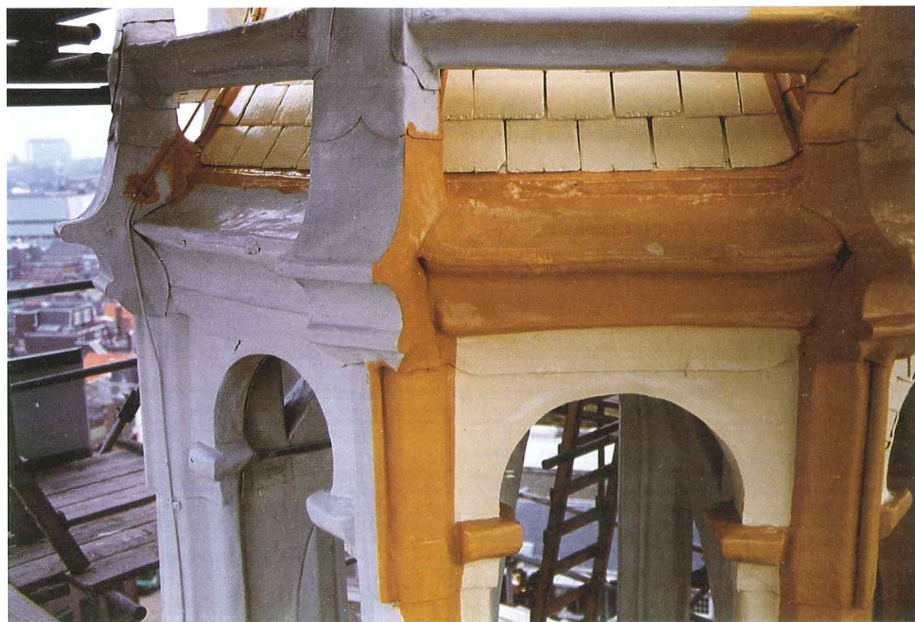
43. Opbrengen van de verschillende kleurlagen.
