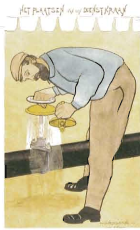
Tekening van het plaatsenvan een dienstkraan (verzameling GA).
