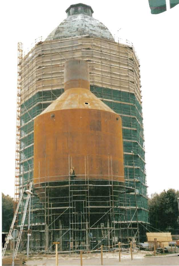
Het nieuwe reservoir in aanbouw (foto 1989, J.J. Havelaar).
