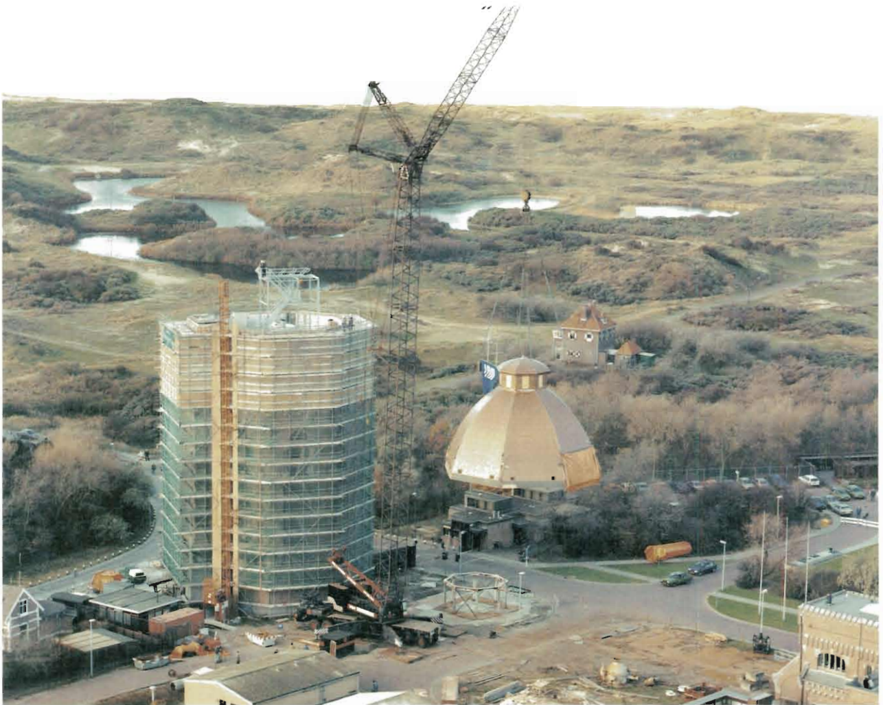
Plaatsing van de nieuwe kap op de watertoren in 1989 (foto, Flying Camera Eindhoven).
