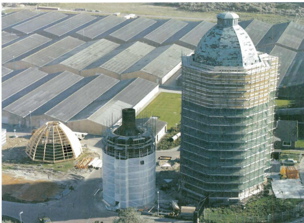
De watertoren in de steigers, met links in aanbouw de nieuwe kap en het nieuwe reservoir, 1989 (foto, Flying Camera Eindhoven).
