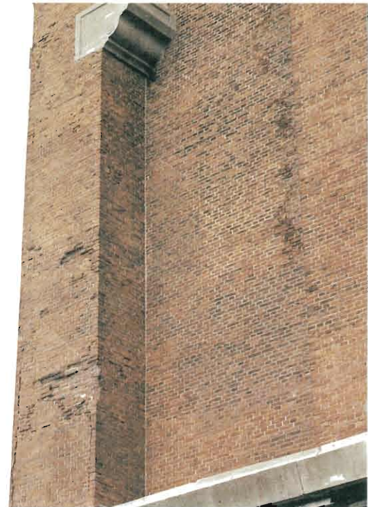
Schade aan het metselwerk van de watertoren in 1988 (foto, Flying Camera Eindhoven).
