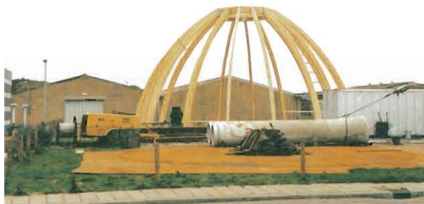
De watertoren in de steigers, met links in aanbouw de nieuwe kap en het nieuwe reservoir, 1989 (foto, Flying Camera Eindhoven).
