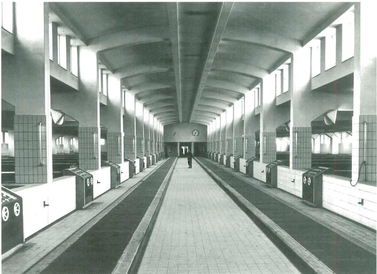
Interieur van het filtergebouw te Bergambacht, 1955 (foto Stokvis, verzameling GA).
