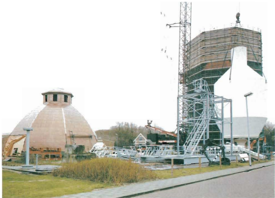
Het nieuwe reservoir wordt in de watertoren geplaatst, 1989 (foto, Flying Camera Eindhoven).
