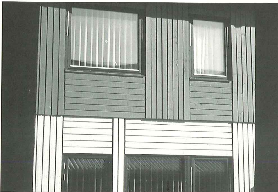
Volgens de Stichting Hout Research is acetyleren een van de meestbelovende technieken om laagwaardige houtsoorten te verbeteren. Behandeld hout moet wel nog steeds worden beschermd door verf.
