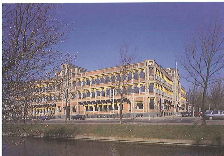
Voor het voormalige hoofdkantoor van de Nederlanden van 1845 wilden Monumentenzorg en de Duitse projectontwikkelaar precies hetzelfde: het gebouw in oude luister herstellen.
