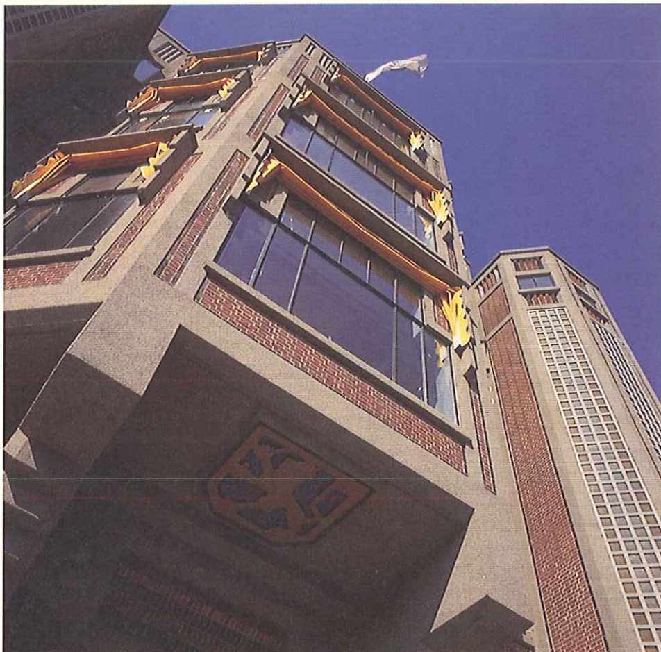
De stalen kozijnen waren nog zo goed, dat een nieuwe verlaag voldoende was. Omdat in de nieuwe situatie isolatieglas 4-6-4 moest worden toegepast en de staalprofiel diktes variëren van 28 tot 38 mm, was er geen ruimte meer voor glaslatten. De Spaanse aannemer heeft dit opgelost door het glas met een zwarte polyurethaan kit direct af te werken.
