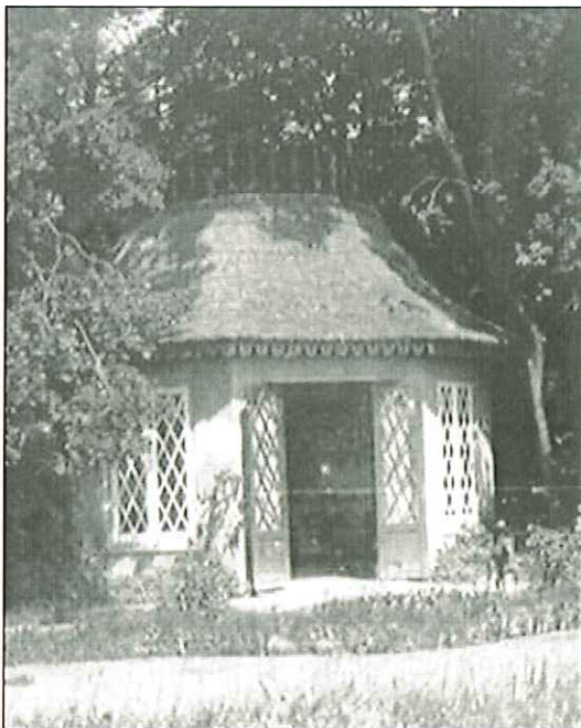
Afb. 2.34 Foto van de koepel met "kraaiennest", ca. 1930. De balustrade is duidelijk zichtbaar. Foto collectie familie Van der Willigen.
