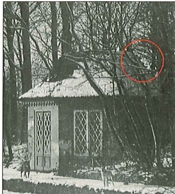
Afb. 2.35 Foto van de koepel, ca. 1930. Aan de achterzijde zijn treden naar het platform te zien. Foto collectie familie Van der Willigen.
