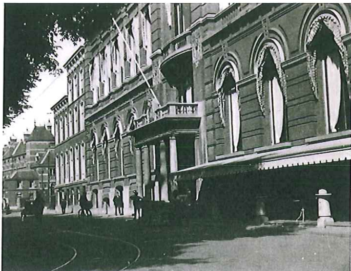
Het gebouw van Sociëteit De Witte voor de uitbreiding van 1930–1932 // The Sociëteit De Witte building before the expansion of the 1930s
