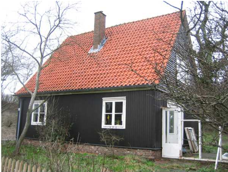
Afb: Houten gevel met stenen voet
