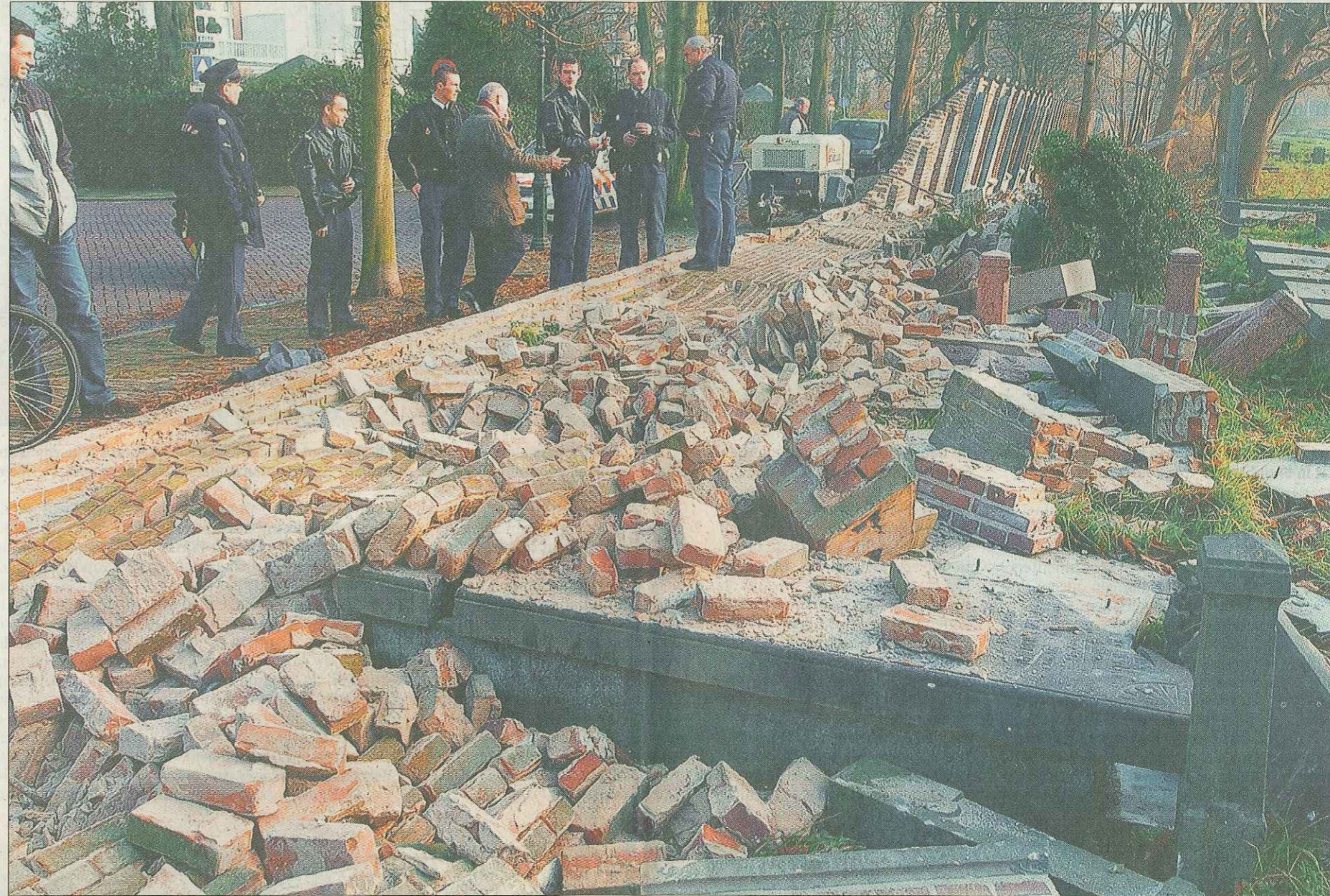
De restanten van de omgevallen muur op de Joodse Begraafplaats. Het bouwwerk begaf het tijdens een poging om de muur te stutten. foto Jos van Leeuwen
