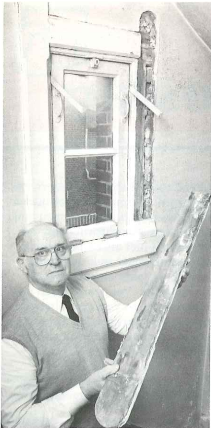
Kieren en ramen aan alle kanten.
