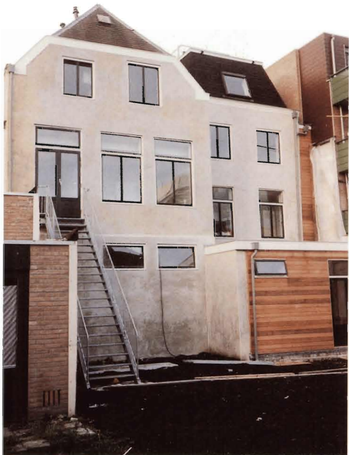
Kranestraat 54 en 56: achtergevels na restauratie.
