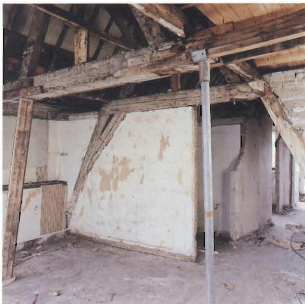
Het vrijwel geheel weggezaagde spant.
