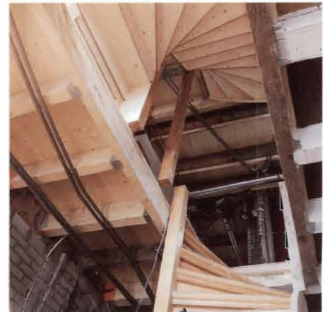
De nieuwe trap naar de eerste verdieping werd verplaatst naar de hoofdentree, aan het begin van de monumentale gang, en is uitgevoerd in eikehout met dezelfde profilering als de bestaande eiken trap.
