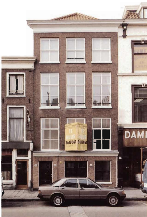
Wagenstraat 169 na restauratie.
