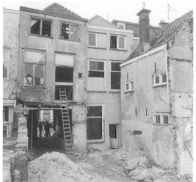
Achterzijde Stille Veerkade 2b en 4 tijdens restauratie.
