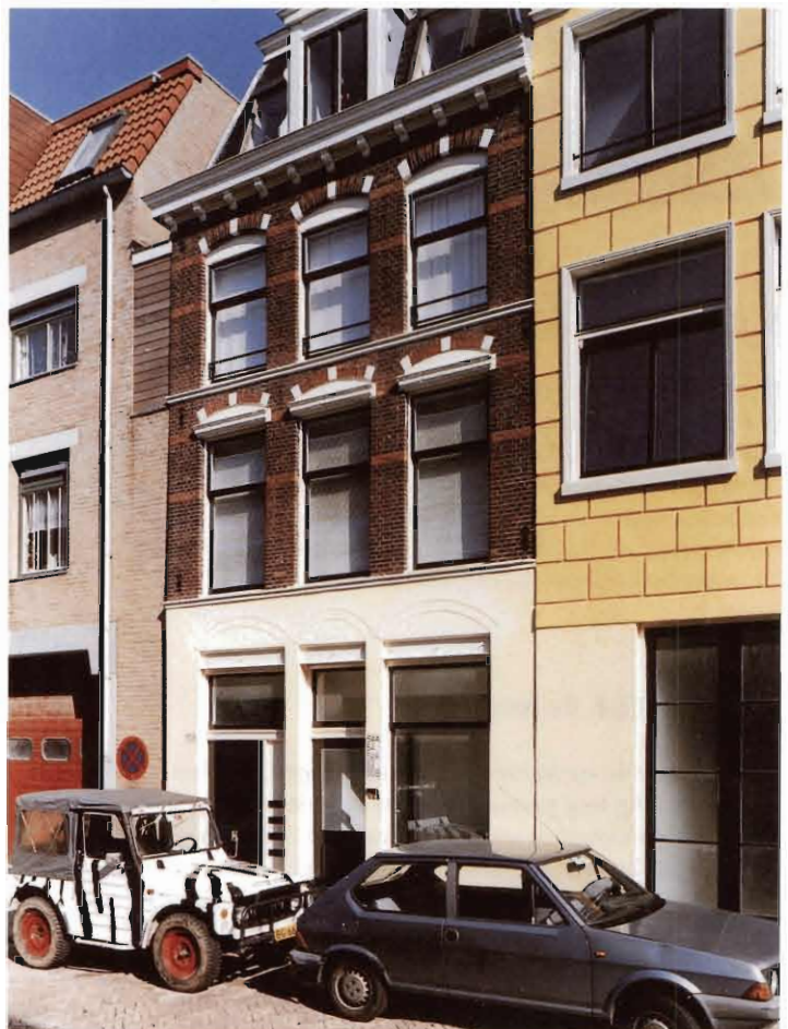
Voorgevel Kranestraat 54 na restauratie.
