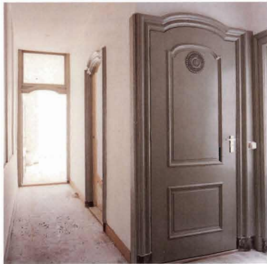
De gang van de begane grond na restauratie: de eiken deuren zijn aan de bovenzijde getoogd en vormen een symmetrie met de muurnissen.
