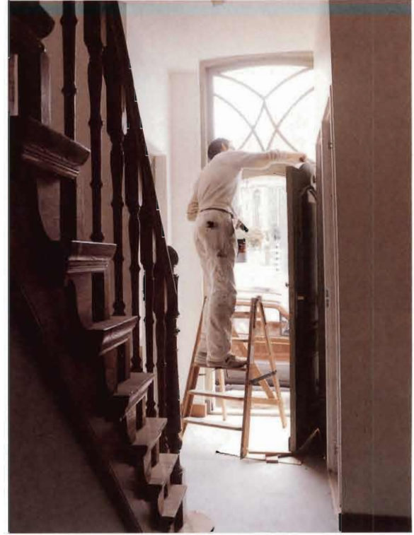
De nieuwe trap naar de eerste verdieping werd verplaatst naar de hoofdentree, aan het begin van de monumentale gang, en is uitgevoerd in eikehout met dezelfde profilering als de bestaande eiken trap.
