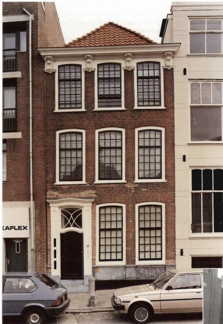
Boven: het pand na restauratie; de voorgevel heeft weer zijn 18de-eeuwse indeling teruggekregen met de monumentale entreepartij. Rechts: de situatie voor restauratie.
