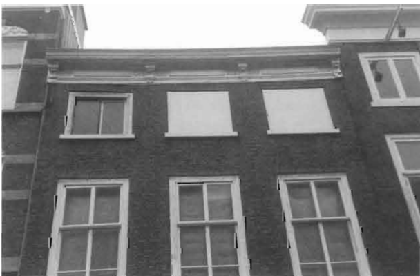
De Nieuwe Molstraat 16, voor- gevel eerste en tweede verdieping voor restauratie.
