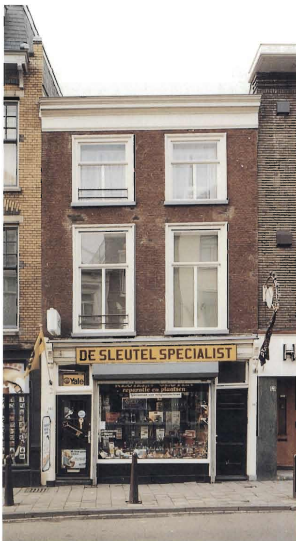
Wagenstraat 143 na restauratie.
