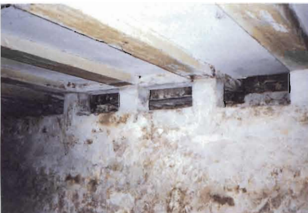
De kelder met zijn isolerende plafond
