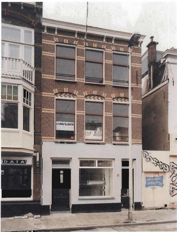
Stille Veerkade 7, na renovatie. Door de gevelreiniging zijn de verschillende kleuren in het metselwerk weer goed zichtbaar geworden.
