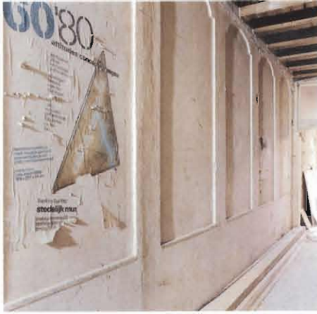
De muurnissen voor de restauratie.
