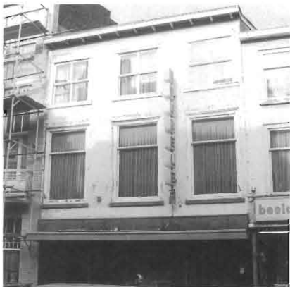
Wagenstraat 104 voor restauratie.
