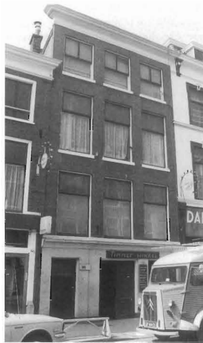
Wagenstraat 169 voor restauratie.
