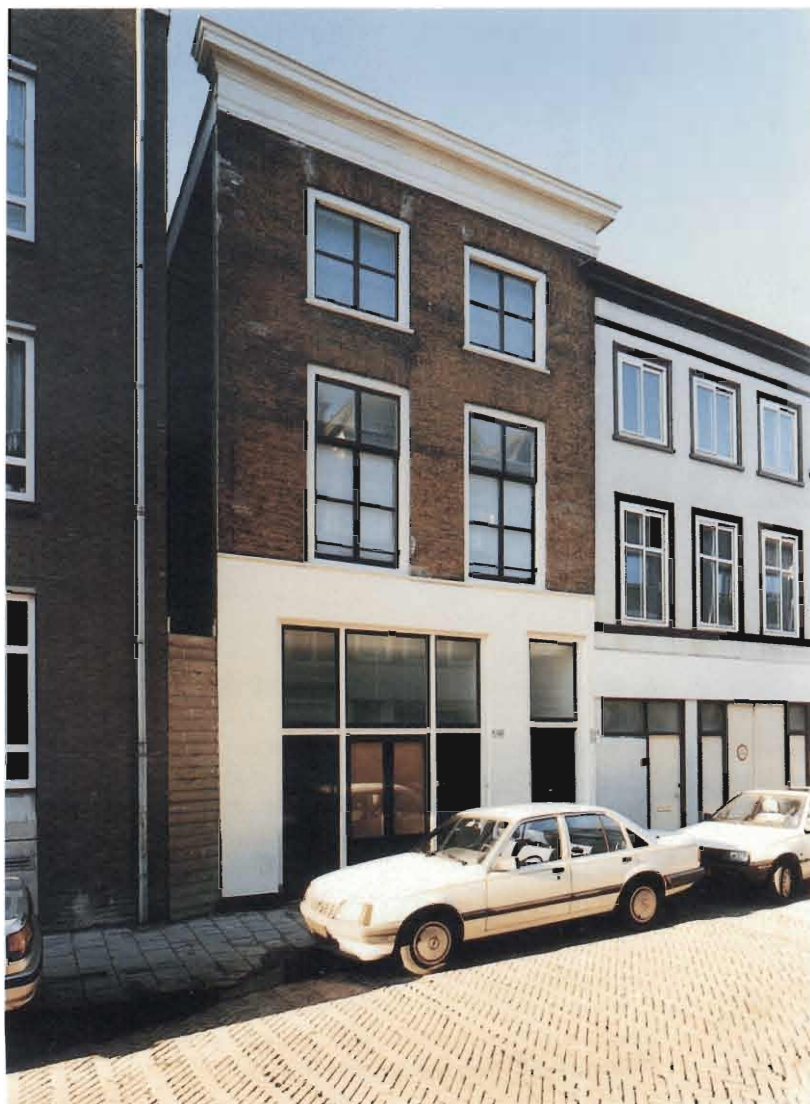
Kranestraat 59, voorgevel na restauratie.
