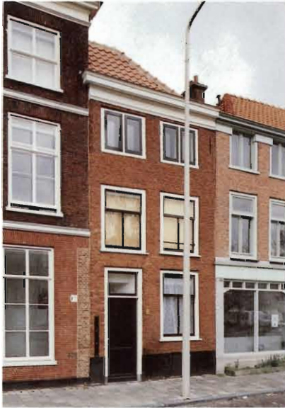
Zuidwal 4 ABC na restauratie.
