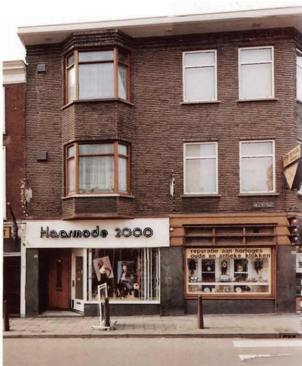
Wagenstraat 141, de gevel na de restauratie waarbij alleen de ramen in de erker vervangen werden.
