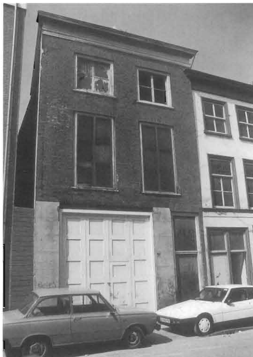
Kranestraat 59, voorgevel voor restauratie.
