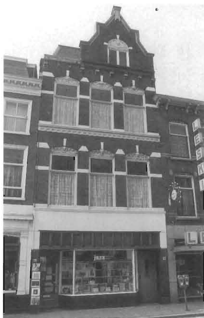
Wagenstraat 125 voor restauratie.
