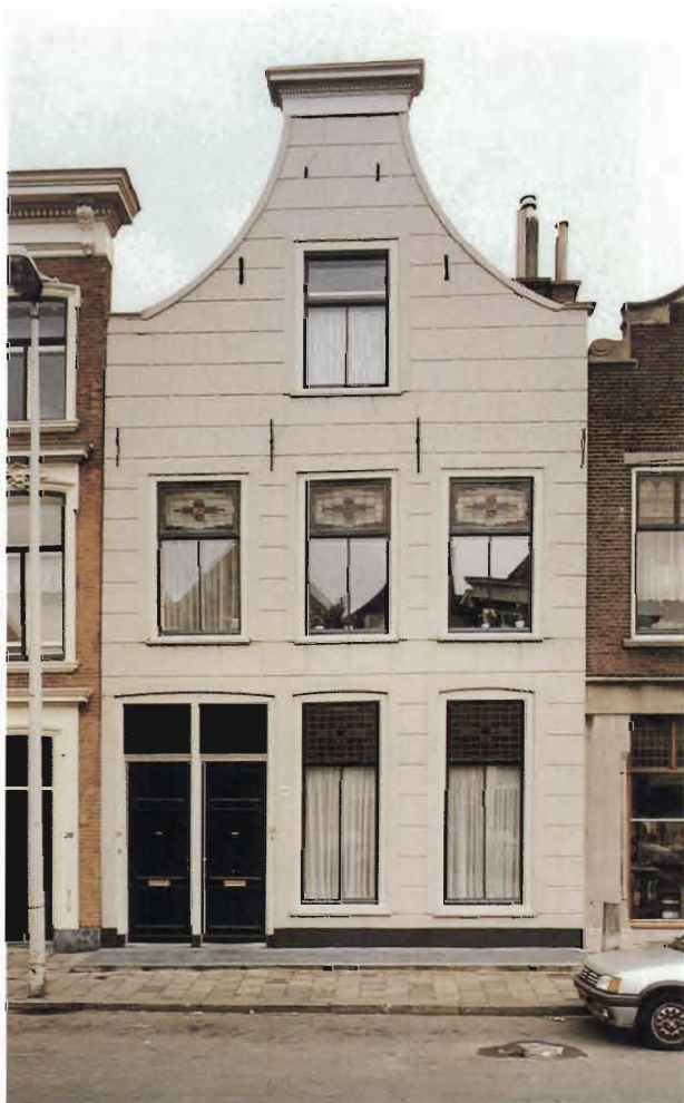
Stille Veerkade 30 na restauratie, met nieuwe paneeldeuren.
