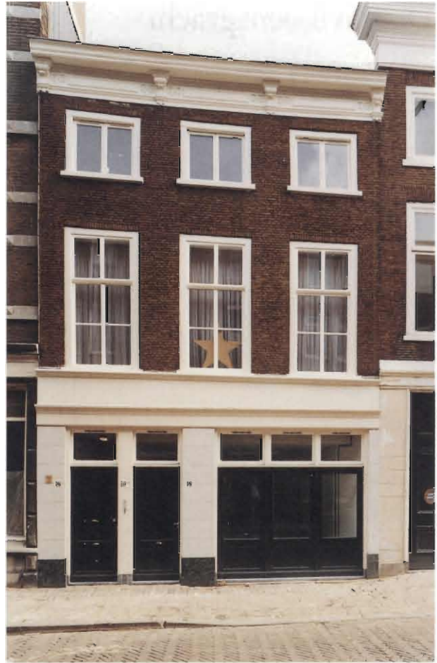
De Nieuwe Molstraat 16, voorgevel na restauratie met zijn fraaie herstelde kroonlijst.
