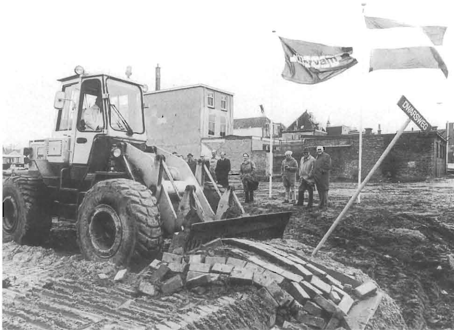
Wethouder Adri Duivestein verwijdt persoonlijk het laatste stukje Dwarsweg, 1981.
