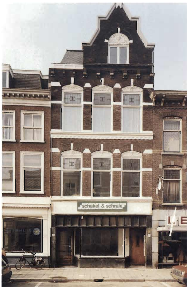
Wagenstraat 125 na restauratie.
