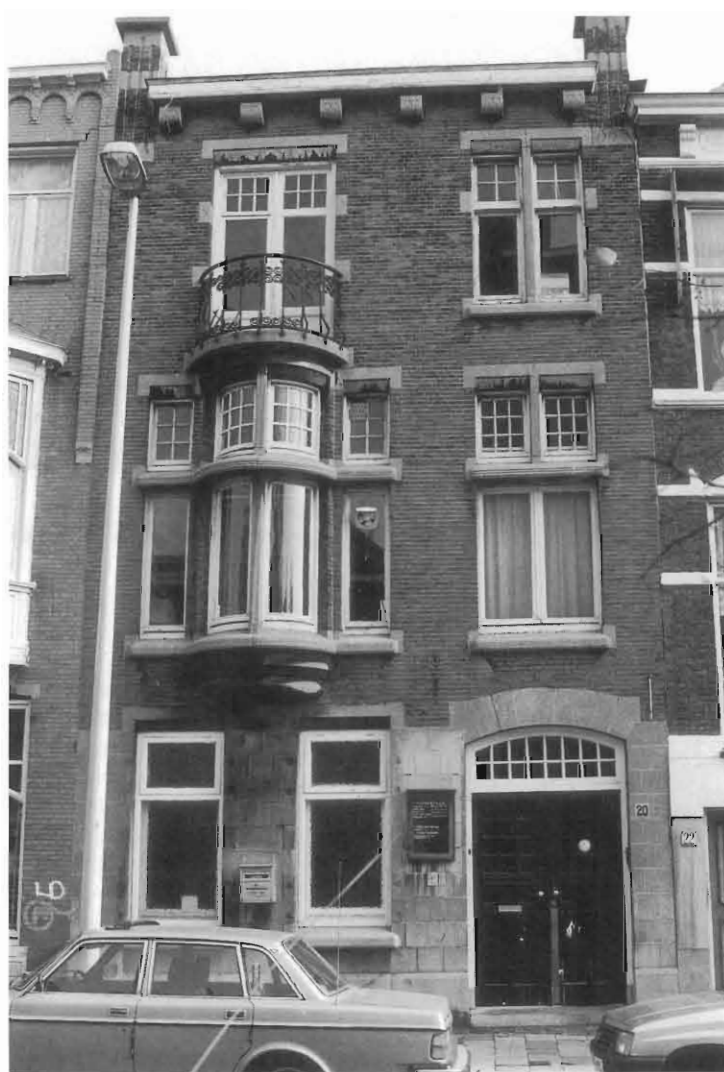
De voorgevel van Stille Veerkade 20 voor restauratie.
