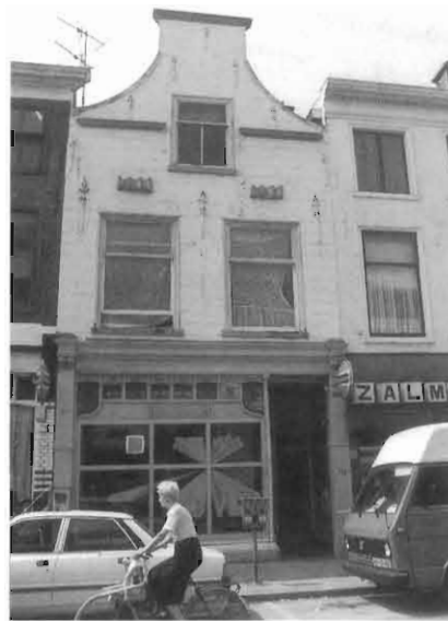
Wagenstraat 115 voor restauratie.
