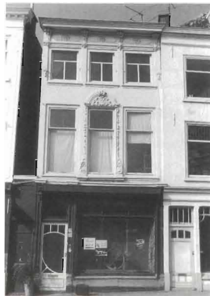
Spui 229 voor restauratie.
