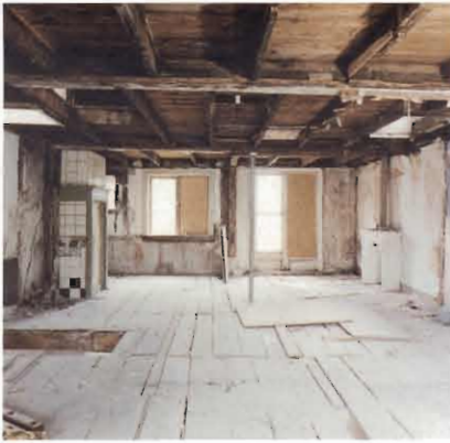
De zolder voor restauratie met de muurstijlen in gevel en bouwmuren.
