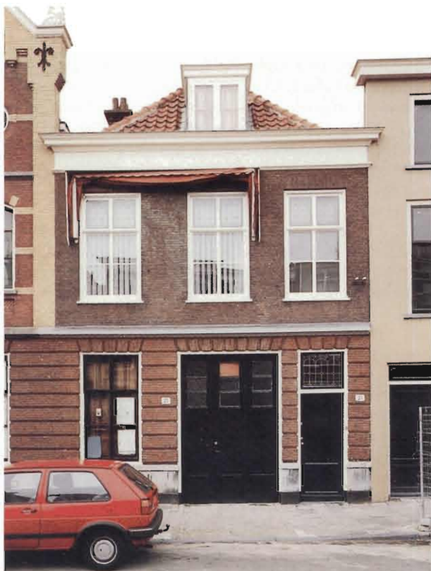
Stille Veerkade 23 en 25 na restauratie, waarbij de gevels vanwege het fraaie metselwerk gereinigd werden en waarbij de Empire raamverdeling van nr. 23 hersteld is.
