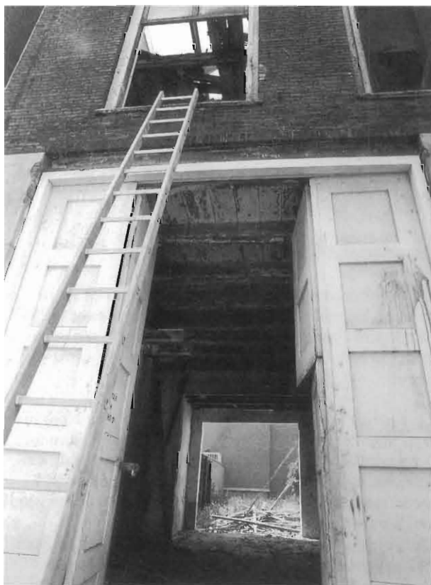
Kranestraat 59, tijdens de verbouwing.
