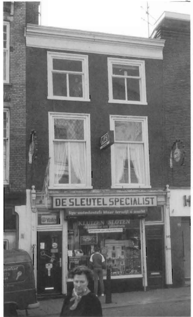
Wagenstraat 143 voor restauratie.
