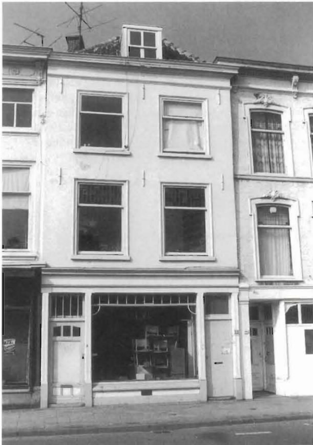
Spui 227 voor restauratie.
