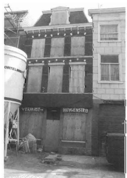
Voorgevel tijdens restauratie.
