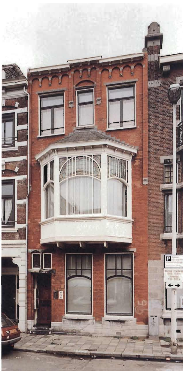
Stille Veerkade 18 na restauratie. De verhoging uit 1912 is nauwelijks herkenbaar.
