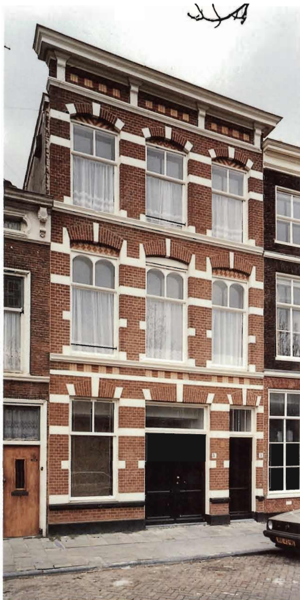
Zuidwal 5 na restauratie, voorzien van nieuw voegwerk en een nieuwe voordeur.
