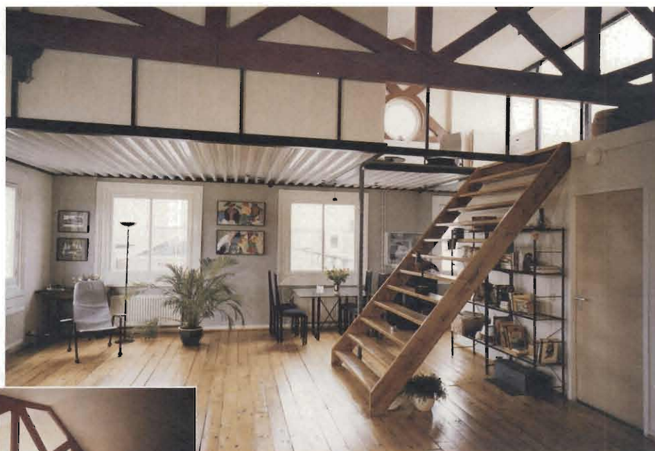
Woning in de kap met in het zicht gebleven houten spant- constructie. (foto's Dienst REO)
