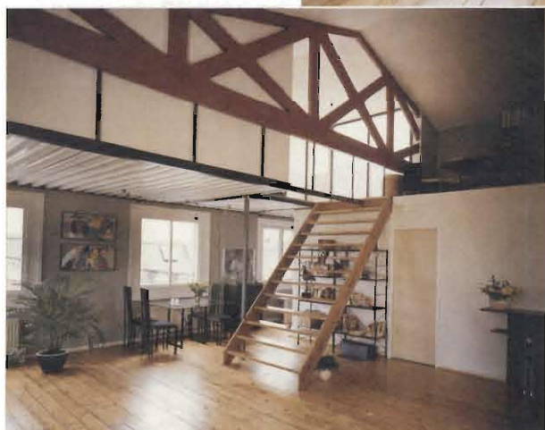
Woning in de kap met in het zicht gebleven houten spant- constructie. (foto's Dienst REO)
