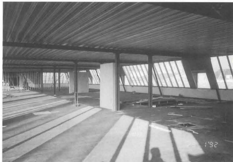
De nieuw gemaakte kapverdieping op de lange vleugel van het gebouw.
