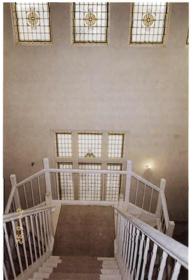
Gedeelte van de nieuwe trap in de monumentale hal aan de Hooftskade.
