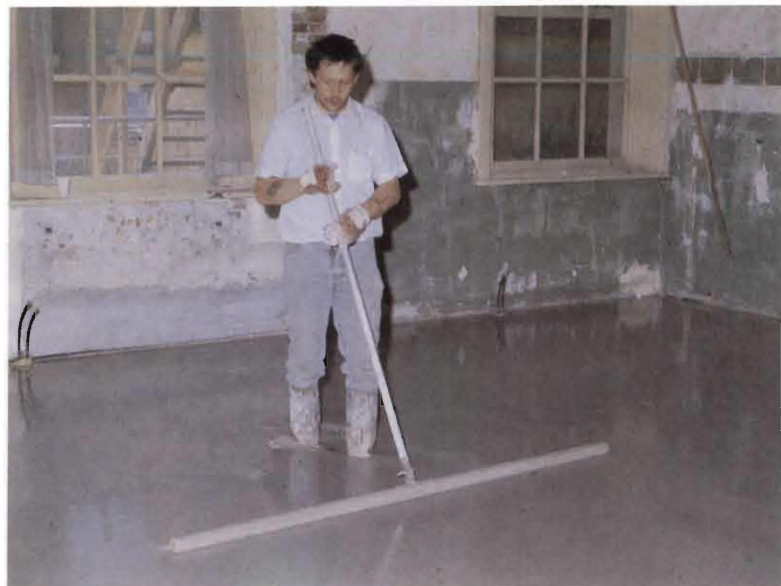
Het gieten van de anhydrietvloer. (foto's Fotobureau Henk van der Veen, i.o.v. Novem)
