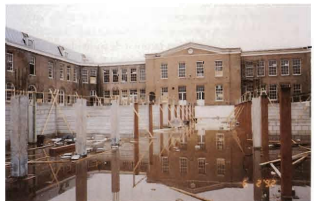
De bouw van de parkeergarage. Het parkeren gebeurt onder de grond, zodat er een aantrekkelijk binnenterrein kan ontstaan.
