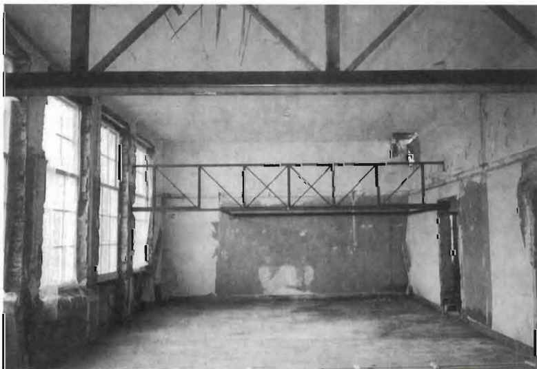
Na de sloopwerkzaamheden worden eerst de entresolbalken aangebracht.
